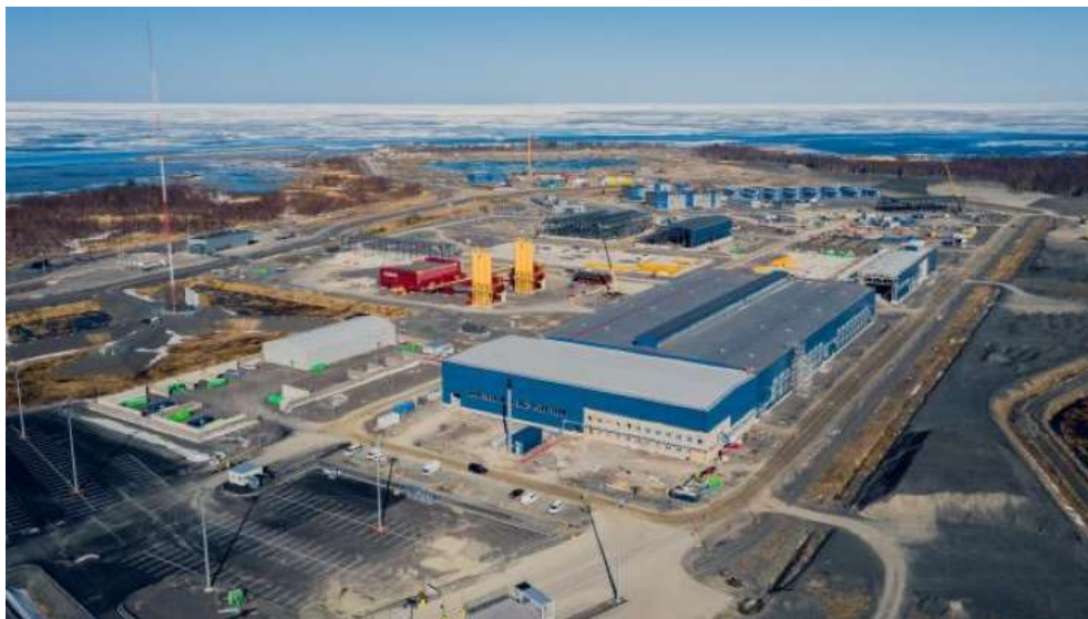
Staveniště Hanhikivi 1 (Obrázek: Fennovoima)
