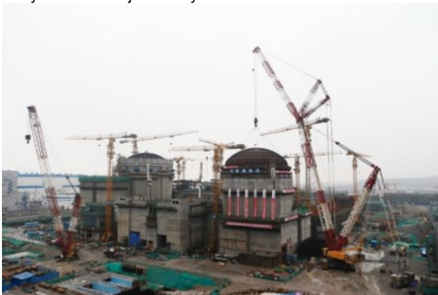
Osazování vrchlíku kontejmentu JE Tianwan 6
