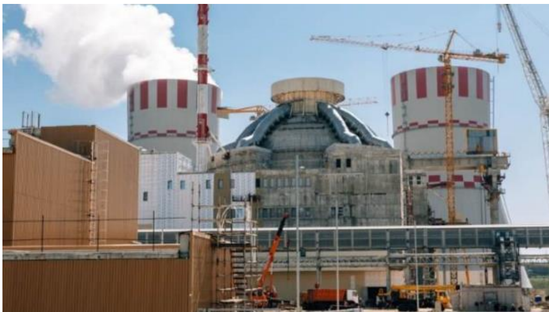
Výstavba JE Novovoronež II-2 v jihozápadním Rusku (Image: Rosatom)
