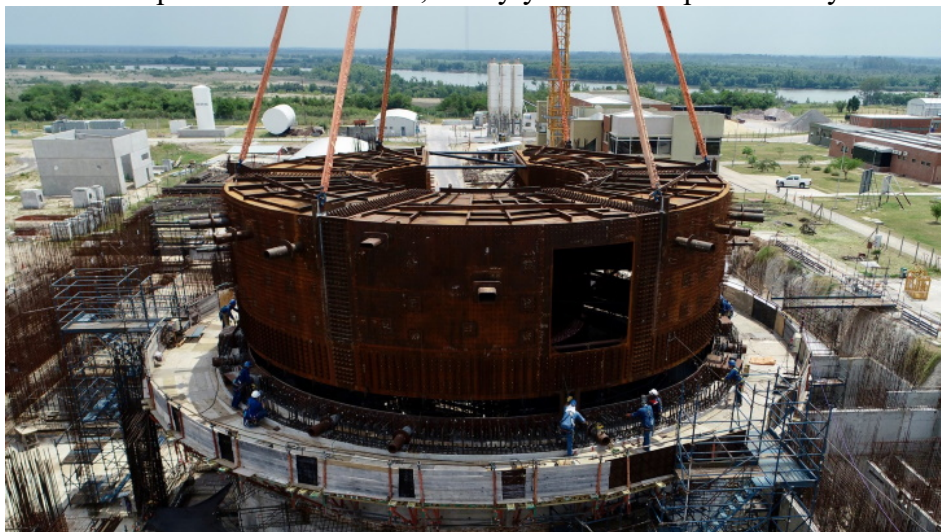
Instalace jednoho z modulů pro reaktor CAREM v listopadu 2020 (Obrázek: CNEA)
