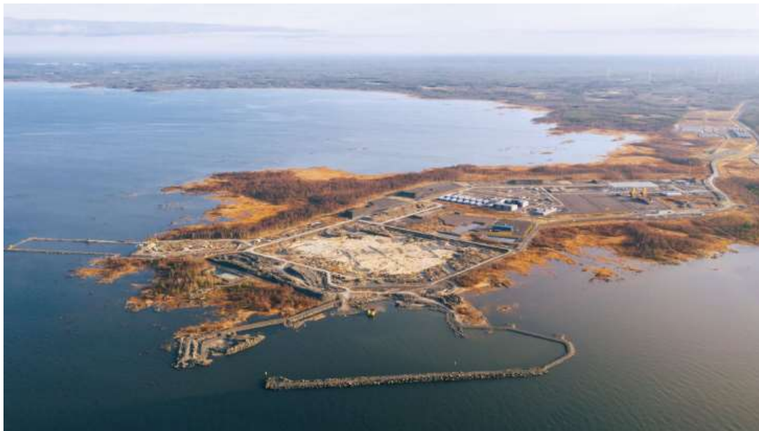
Staveniště finské elektrárny Hanhikivi, tam by se výstavba reaktoru měla rozběhnout v roce 2021 (Fennovoima).
