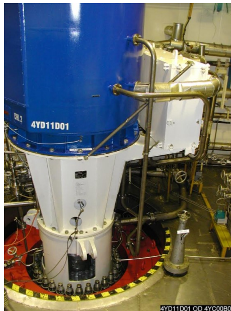
Celkový pohled na osazené HCC
