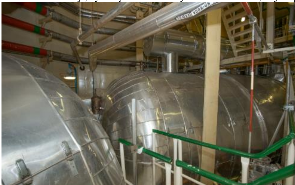
Dva z celkem dvaceti čtyř parogenerátorů EDU (šest na blok)
