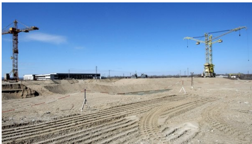
Současný stav JE Belene – základová jáma se základovou deskou a uskladněné komponenty za téměř 620 milionů eur. (Zdroj: Rosatom)
