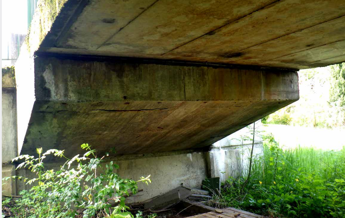
▲ Obr. 8 Pohled zespodu na kotevní blok – hvězdonickou opěru a čelní pohled na ocelové desky kluzného uložení visutého pásu na konzole kotevního bloku
