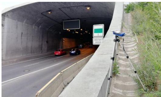
Obr.5: Měření za běžného provozu – poloha mikrofonu S.J2 u jižního portálu Strahovského tunelu
