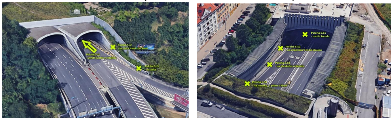
Obr. 1 a 2: Jižní a severní portál Strahovského tunelu – měření za provozu
