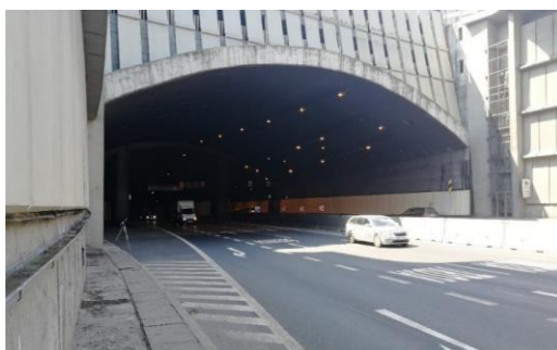
Obr.6: Měření za běžného provozu – poloha mikrofonu S.S2 u severního portálu Strahovského tunelu
